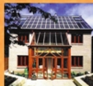
Edificio bioclimatico alimentato al con energie rinnovabili ad un sole: sistemi solari termici, fotovoltaici.
