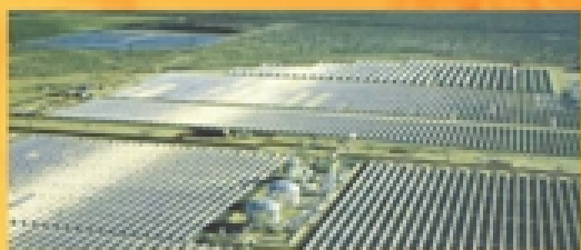
Impianto solare a concentratori parabolici lineari di 354 MWe, deserto del Mojave, California. Fonte: SolarPaces
